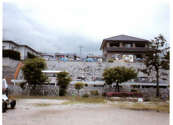
写真6 擁壁式の丘陵造成地における木造屋根被害（廿日市市阿品台）
