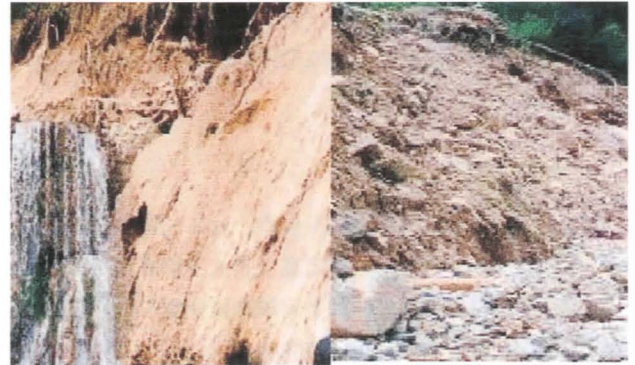
図-13 流出後の斜面状況 (H11.7.1撮影)
