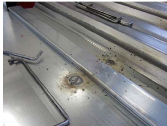
写真 14 焼抜き栓溶接状況
