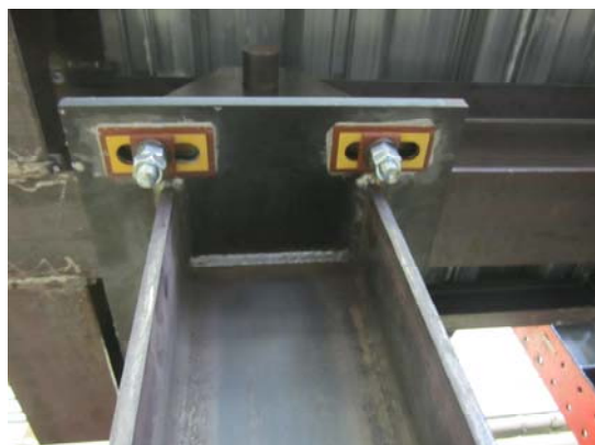
写真 12 ローラー支点 (下から撮影)
