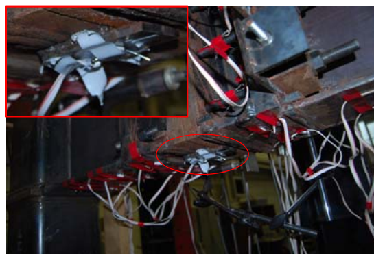
写真 7 せん断抵抗材取付け状況
