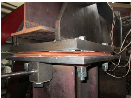
写真 3 ローラー支点
