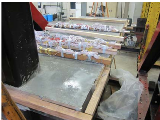
写真 15 コンクリート打設完了
