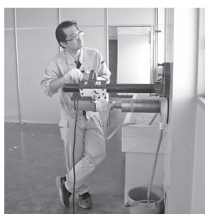
写真2 コアボーリング
